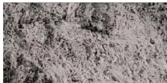
Beton nach Behandlung mit DRS-FLOOR HDP
