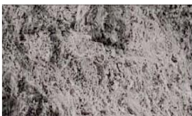
Beton nach Behandlung mit DRS-FLOOR HDS+
